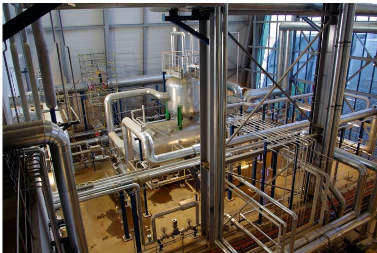
F/ Wnętrze hali budynku procesowego (fot. KHK S.A. Kraków).
