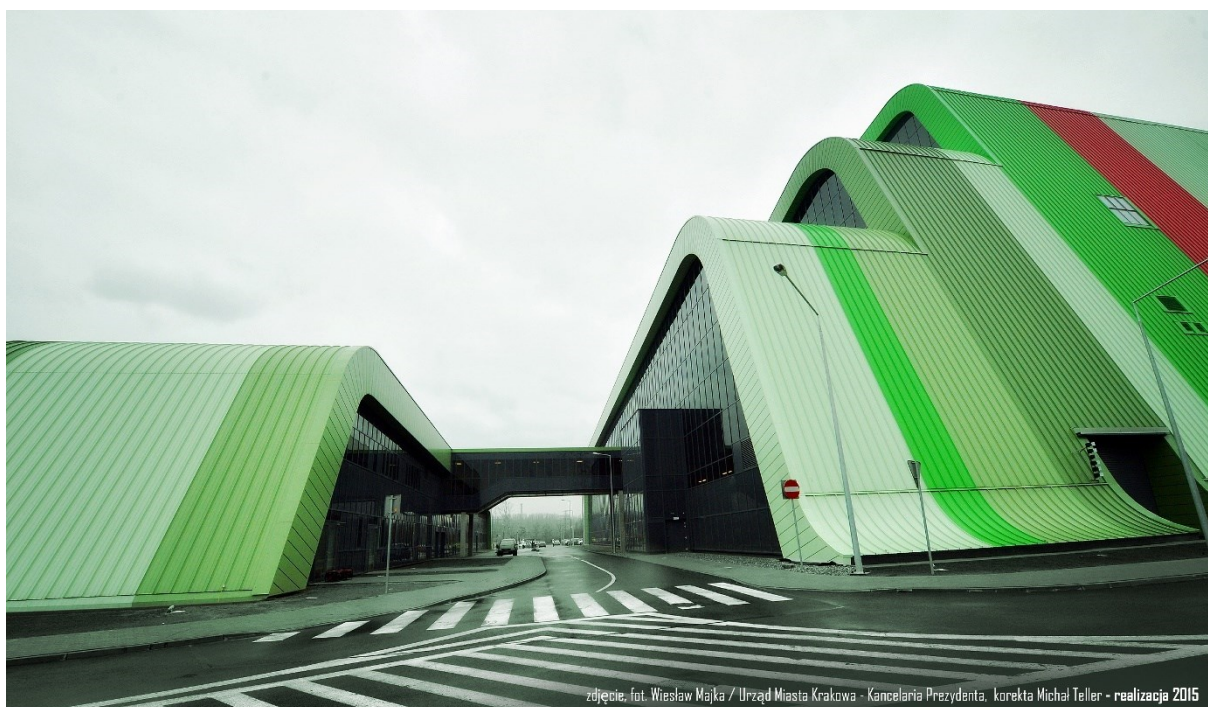
D/ Widok ZTPO od strony łącznika planie (fot. KHK S.A. Kraków)
