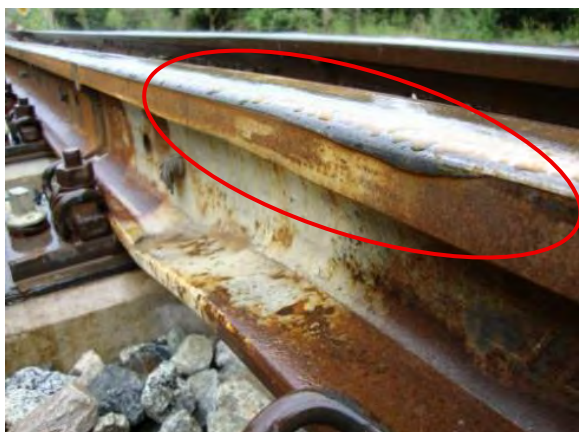
Rysunek 2.20. Defekty iglicy a) zniekształcona główka szyny [48] b) wykruszenie materiału na główce szyny [49]
