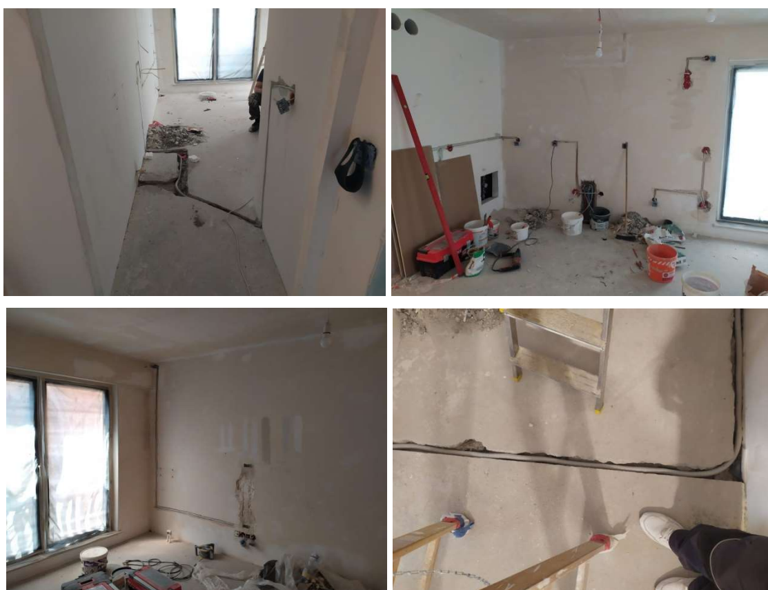
Rys. 23 Ilustracje przedstawiające instalacje elektryczne, tynki, posadzki po wykonaniu zmian lokatorskich [Źródło własne]
