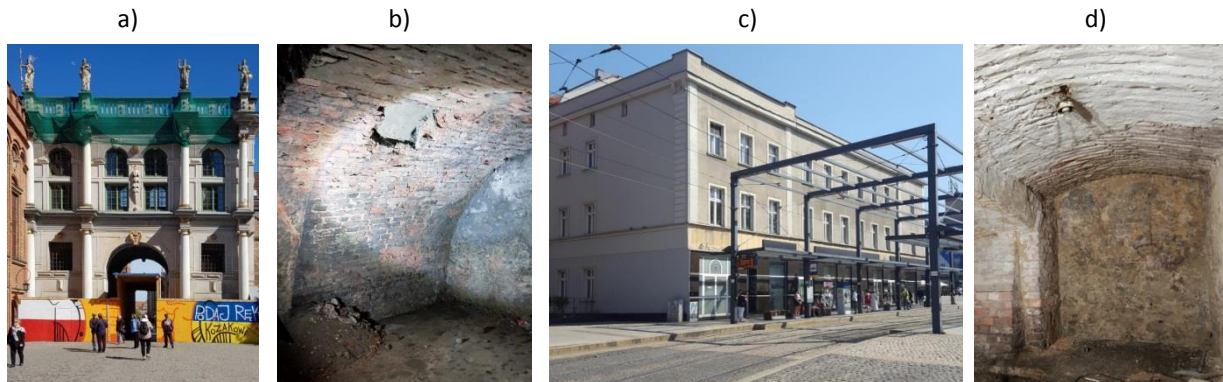
Rysunek 17. Złota Brama w Gdańsku: widok ogólny (a) i fragment sklepienia kolebkowego w jednym z pomieszczeń piwnicznych (b), za [A14] oraz kamienica w Katowicach: widok budynku (c) i przykładowy widok piwnic (d), za [A13]
