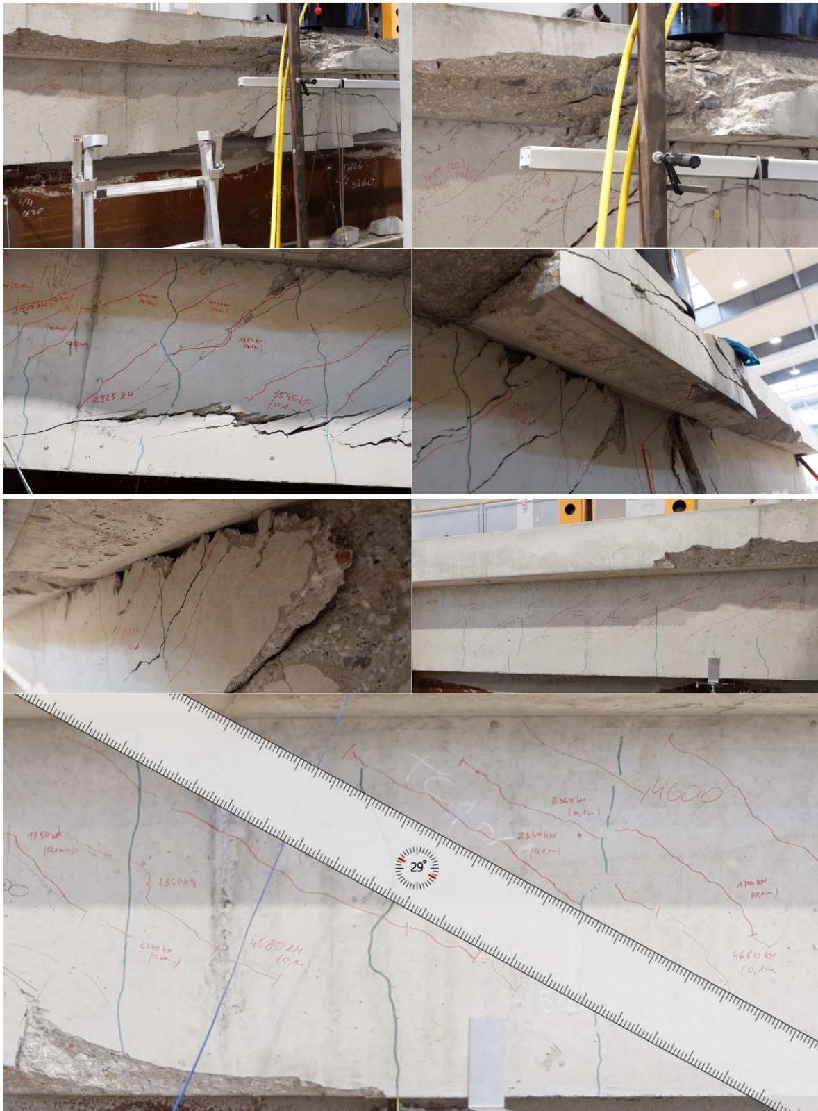
Rys. 6.29 Belka S1-200 bezpośrednio po zniszczeniu przy obciążeniu 7341 kN (S1-200)
