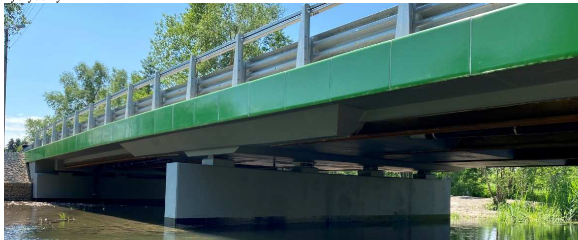
Rys. 8.3 Widok konstrukcji wiaduktu w Biskupicach przekrojów hybrydowych, wymiarowanych na podstawie założeń metody ogólnej [55]. W toku przygotowywania rozprawy doktorskiej w ramach prac wdrożeniowych autor zaprojektował pięć konstrukcji wykorzystujących przekroje hybrydowe, które wymiarowano zgodnie z zasadami przedstawionymi w niniejszej rozprawie.
