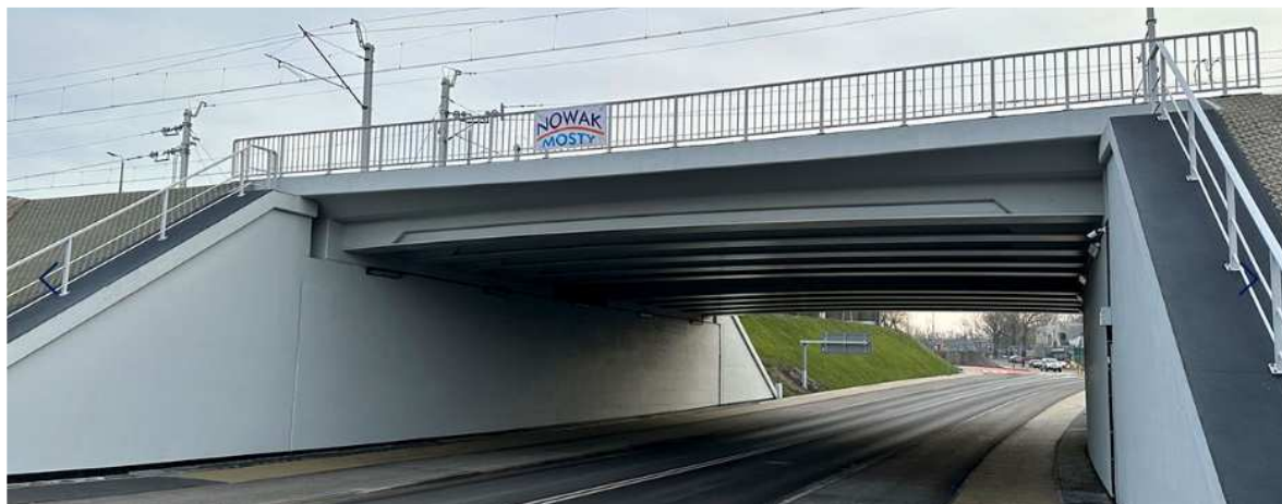
Rys. 8.5 Widok z boku na konstrukcję w Dąbrowie Górniczej w km 300,009 [86]
