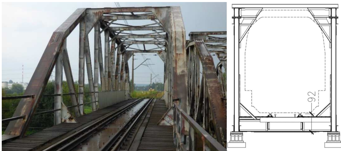
Rys. 2.11 Istniejący wiadukt kolejowy w Dąbrowie Górniczej
