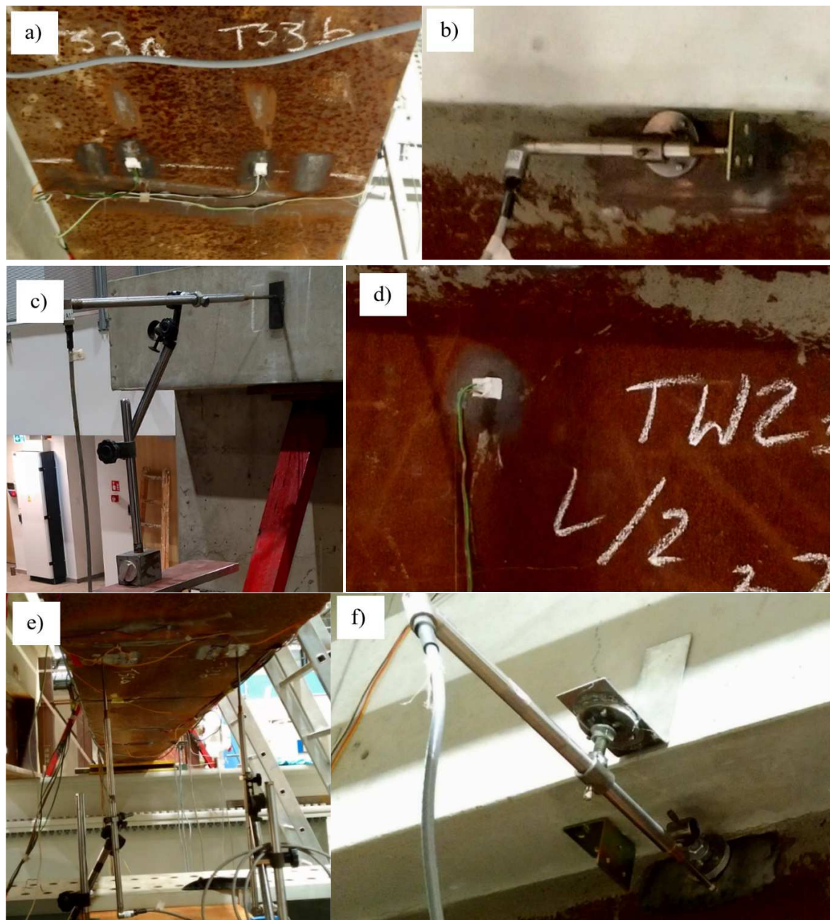
Rys. 6.19 Urządzenia pomiarowe zastosowane na potrzeby przedmiotowych badań a) tensometry (TS3a i TS3b) na dolnym pasie stalowym, b) czujnik indukcyjny do pomiaru poślizgu pomiędzy stalą i betonem w przekroju 25% rozpiętości belki, c) czujnik indukcyjny do pomiaru odkształceń poziomych pólki żelbetowej, d) tensometr (TW2b) do pomiaru odkształceń poziomych środka stalowego, e) czujniki indukcyjne do pomiaru odkształceń pionowych pasa dolnego, f) czujnik indukcyjny do pomiaru względnych przemieszczeń poprzecznych (odsłojenia) pomiędzy betonem i stalą w obrębie zespolenia (SP2a)
