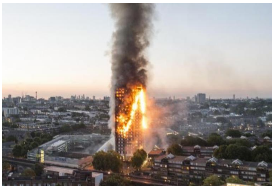
Rys. 3.8. Pożar Grenfell Tower w Londynie w 2017 r. [70]
