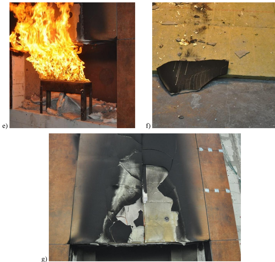
Rys. 5.8. Przebieg badania modelu rzeczywistego w teście skali naturalnej serii D: a) rozpoczęcie badania; b) 13'30" – spada pierwszy element; c) 17'00" – spadają elementy glifu; d) 28'00" – spadają kolejne elementy; e) 28'00" – duże zniszczenie okładziny; f) 55'00" – spadają kolejne elementy; g) widok okładziny elewacyjnej po badaniu
