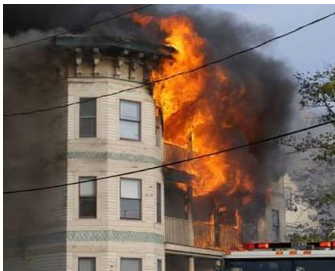
Rys. 3.9. Mechanizm rozprzestrzeniania się pożaru pomiędzy kondygnacjami po elewacji [7, 131]
