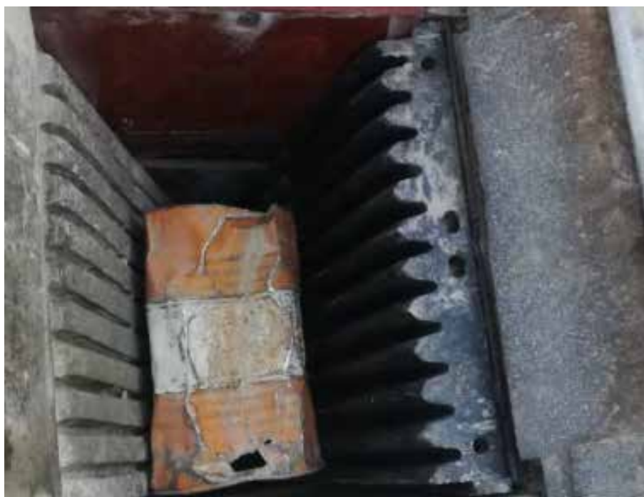
Rys. 2.2. Widok ogólny nowo zamontowanej szczęki stałej w pierwszym dniu eksploatacji (z prawej).
