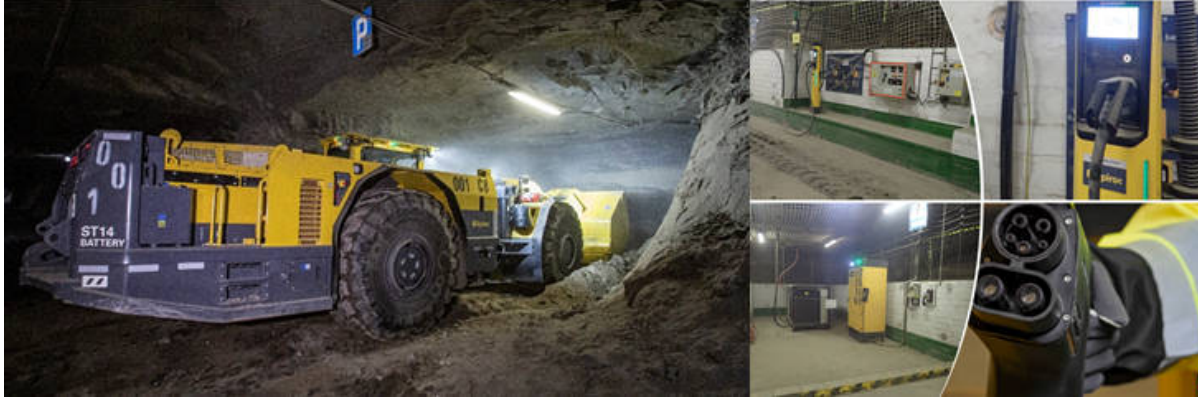
Rysunek 2-16: Ładowarka przegubowa Epiroc ST14B z napędem elektrycznym zasilanym bateryjnie oraz infrastruktura dla obsługi procesu ładowania baterii na KMC (źródło: opracowanie własne)
