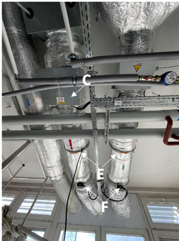
Rysunek 20. Stanowisko pomiarowe oraz zastosowane urządzenia (a) Zdjęcie części instalacji zawierającej badane urządzenia: rotor sorpcyjny i wymiennik wstępny (b) Zdjęcie części instalacji doprowadzającej powietrze do urządzeń
