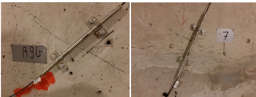
Rys. 17. Czujniki odkształcenia w pkt R9 i R7 zainstalowane wewnątrz przęsła nurtowego
