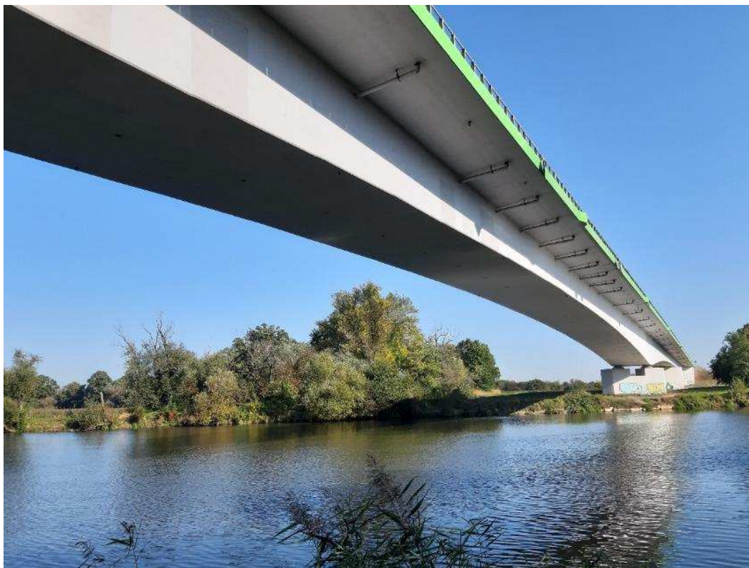
Rys. 9. Widok ogólny przęsła nurtowego mostu [1]
