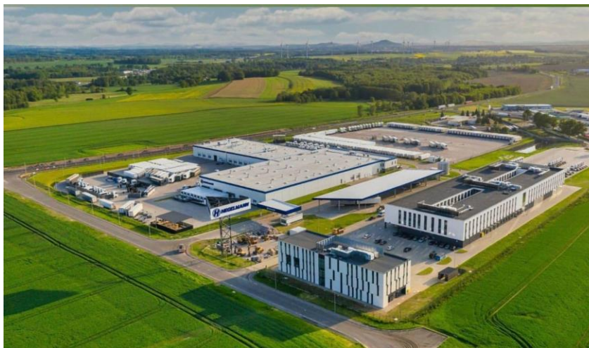
Rysunek 5. Widok wybudowanego kompleksu transportowo – usługowego
