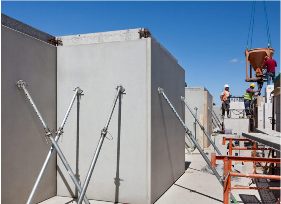
Rys. 1.14 - Zamontowane ściany zespolone zabezpieczone podporami ukośnymi [23]
