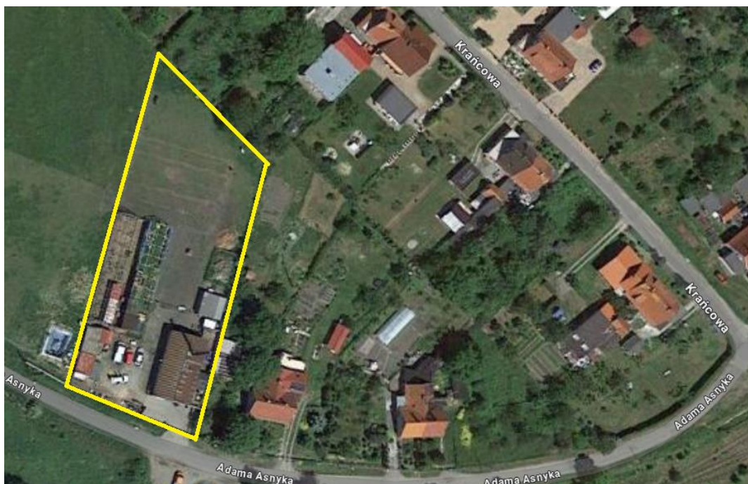
Rys. 5.6 - Widok z lotu ptaka na teren inwestycji „Muflon”
