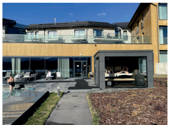
Fot. 92. Hotel Lake Hill Resort & Spa – sauna zewnętrzna [autor: Gronostajska-Kadecka J.]
