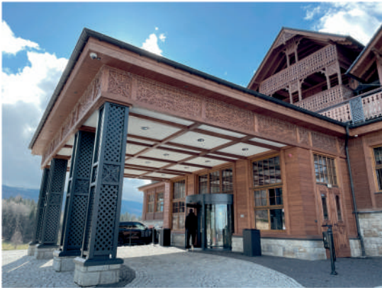
Fot. 64. Hotel Seidorf w Sosnowce – wejście główne [autor: Gronostajska-Kadecka J.]
