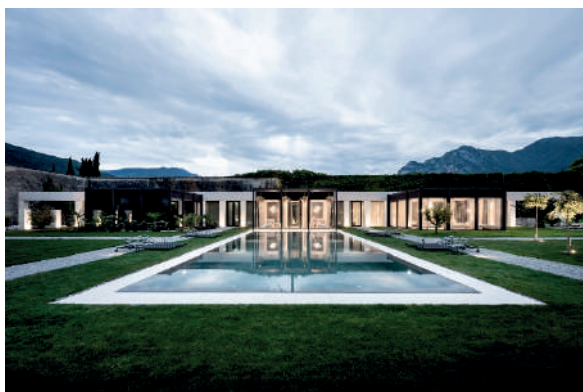
Fot. 9. Hotel Monastero Arx Vivendi w Arco, Włochy – basen zewnętrzny [przedruk z: https://www.archdaily.com/966448/monastero-hotel-noa-star-network-of-architecture , dostęp z dn. 20.10.2022]
