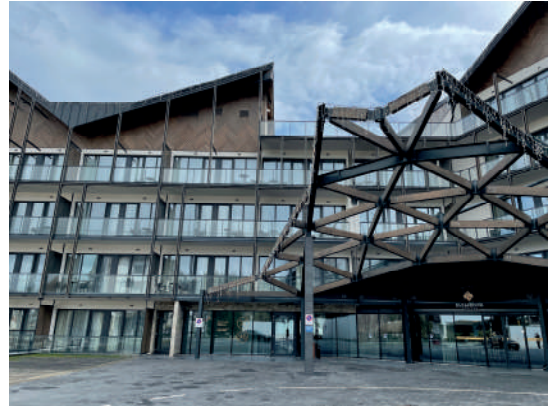
Fot. 35. Hotel Elements Resort & Spa w Świeradowie-Zdrój – wejście główne [autor: Gronostajska-Kadecka J.]
