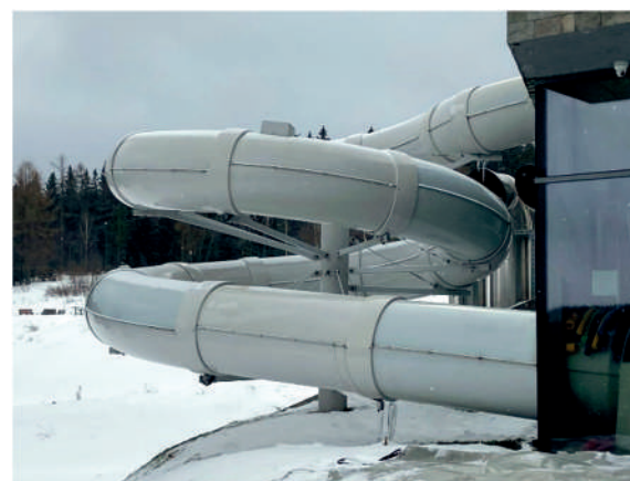
Fot. 122. Radisson Hotel Szklarska Poręba – zjeżdżalnia zewnętrzna [autor: Gronostajska-Kadecka J.]
