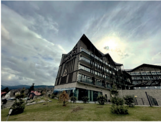
Fot. 34. Hotel Elements Resort & Spa w Świeradowie-Zdrój – widok z zewnątrz [autor: Gronostajska-Kadecka J.]
