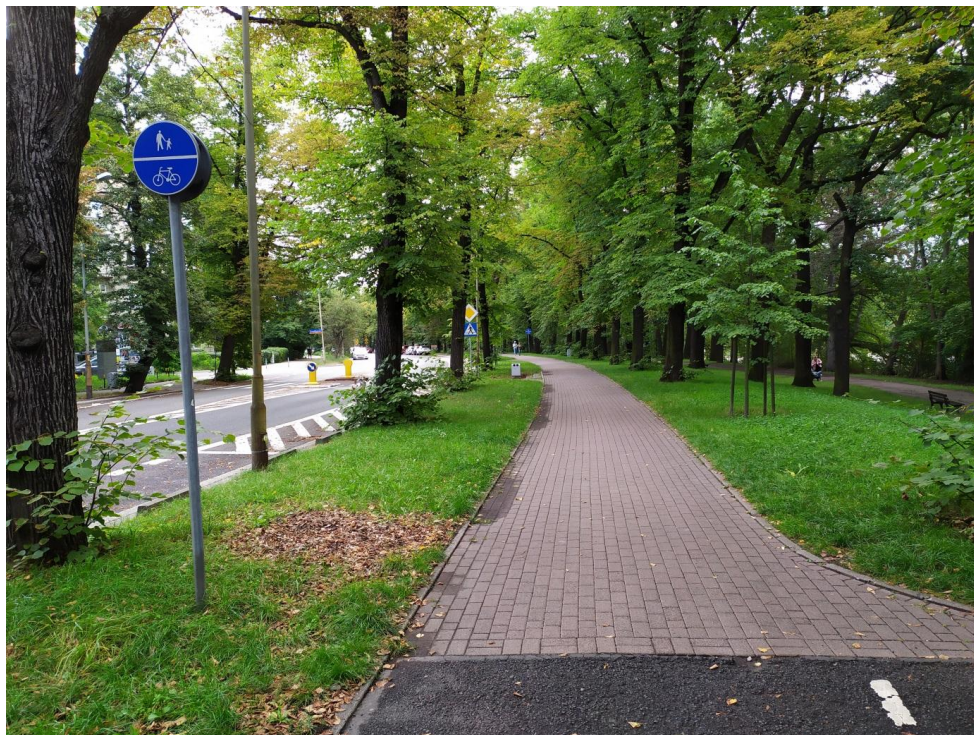
Fot. 2 Wrocław, wyb. Stanisława Wyspiańskiego – Wymieszanie ruchu pieszego i rowerowego pomimo możliwości ich rozdzielania i stworzenia dedykowanej ścieżki pieszej lub rowerowej (po prawej stronie). Źródło: Archiwum własne
