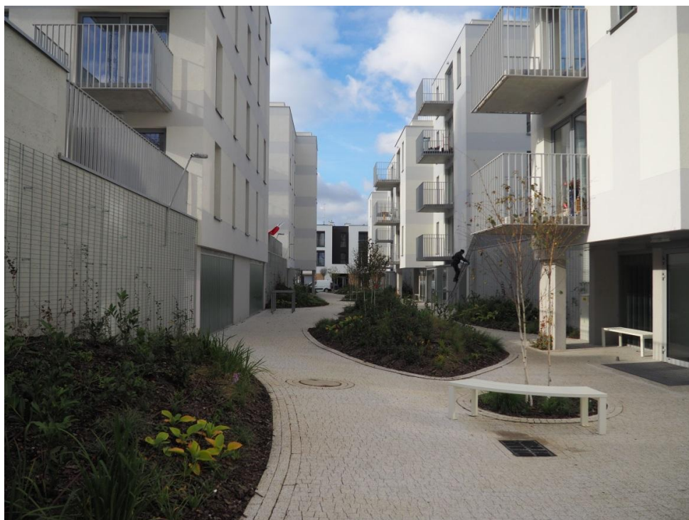
Fot. 10 Wrocław, osiedle Nowe Żerniki, trasa piesza wewnątrz kwartału Źródło: Archiwum własne
