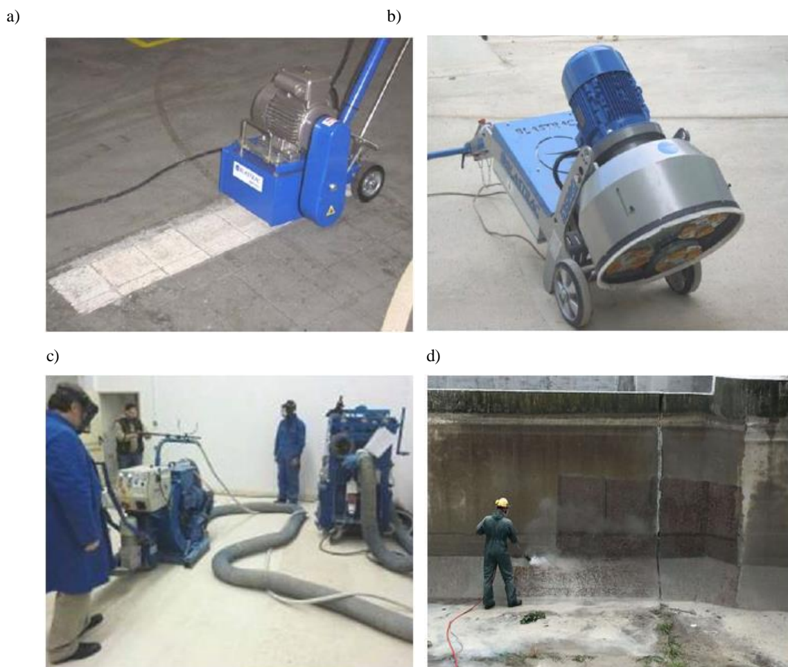
Rys. 3.9. Techniki przygotowania podłoża betonowego [60]: a) widok przygotowania powierzchni betonu przy pomocy frezarki, b) widok urządzenia szlifierki do betonu, c) widok śrutownic przy czyszczeniu betonu, d) widok czyszczenia betonu metodą hydromonitoringu.
