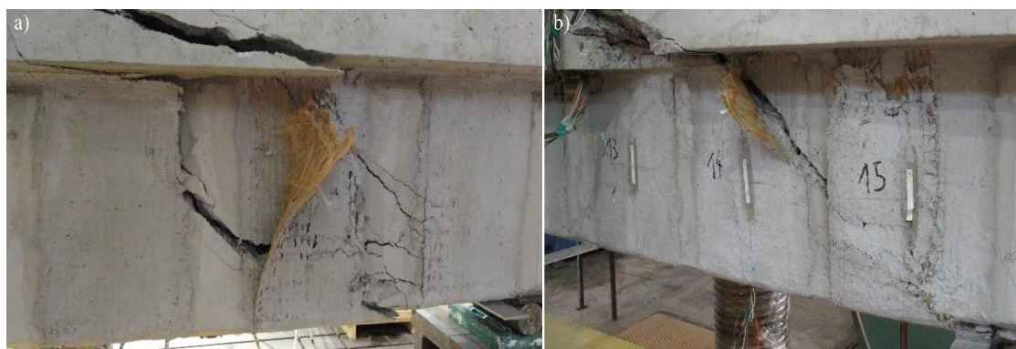
Rys. 4.78. Zniszczenie belki B_P200_BZ – odspojenie końców strzemion PBO nad rysą ukośną.
