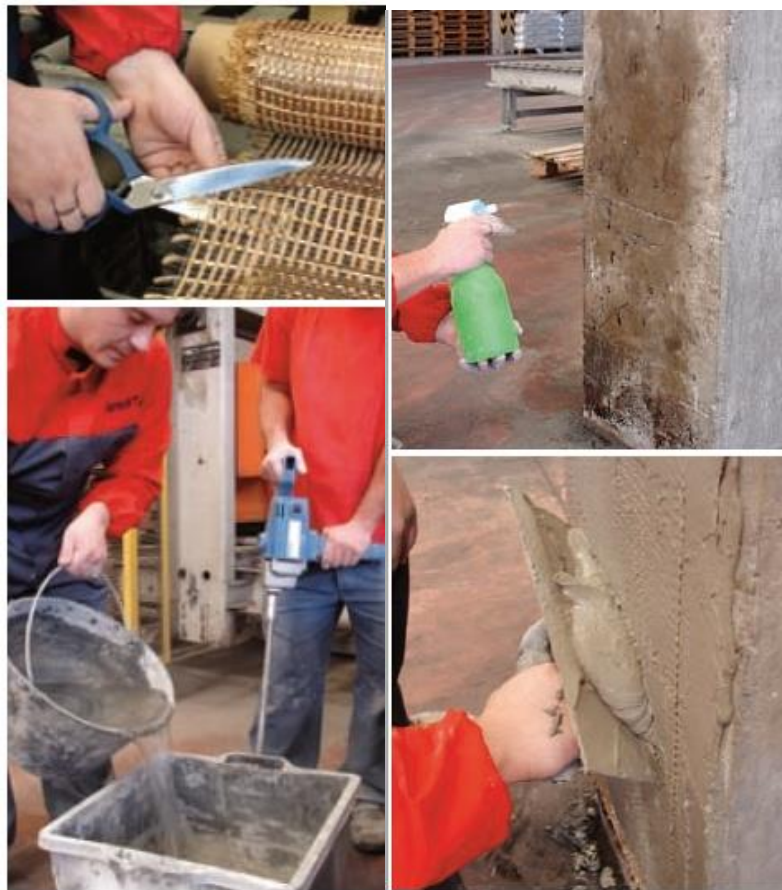
Rys. 2.21. Poszczególne etapy aplikacji systemu PBO-FRCM [106]
