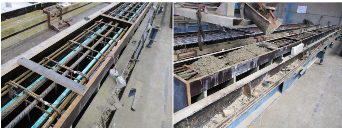
Rys. 4.56. Układanie zbrojenia w formach i betonowanie
