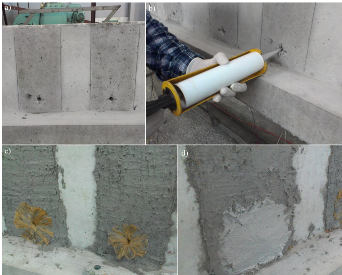
Rys. 4.10. Etapy przygotowania wzmocnienia z zakotwieniem wachlarzowym
