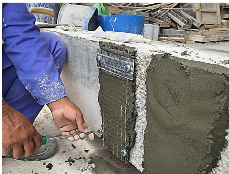
Rys. 2.60. Zakotwienie wzmocnienia FRCM wg [87]
