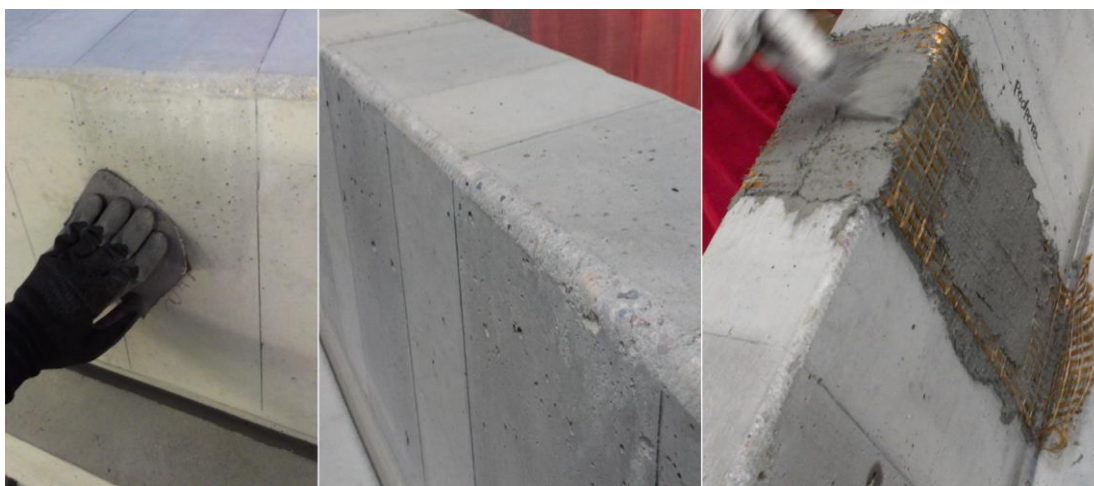
Rys. 4.8. Etapy wzmocnienia – przygotowanie powierzchni poprzez usunięcie mleczka cementowego, wyoblone naroży i aplikacja wzmocnienia
