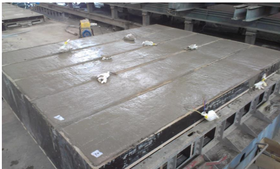
Rys. 4.7. Belki po zabetonowaniu
