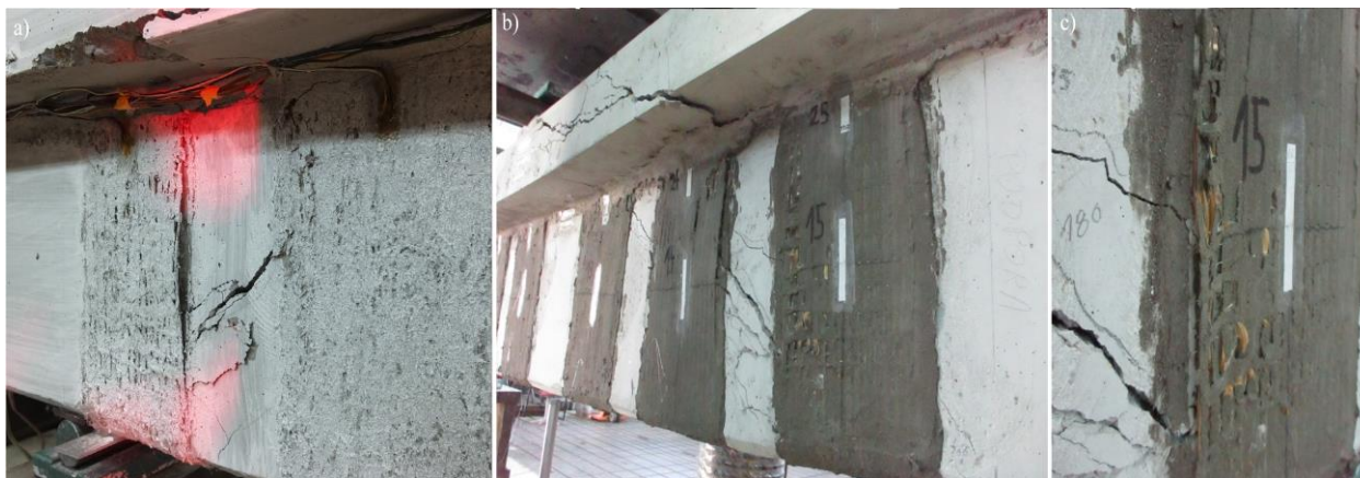
Rys. 4.68. Zniszczenie belek B_P150: a) odspojenie strzemienia PBO nad rysą ukośną w belce B_P150, b) odspojenie strzemienia PBO nad rysą ukośną w belce B_P150_Z, c) widoczne zarysowanie, poślizg włókien na elastycznej zaprawie naprawczej oraz suche włókna
