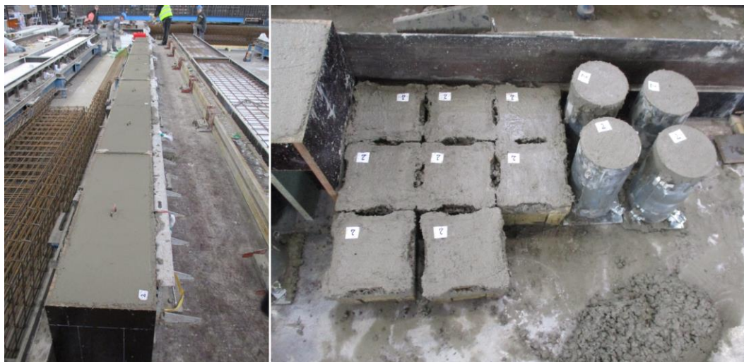
Rys. 4.57. Belki i próbki po zabetonowaniu
