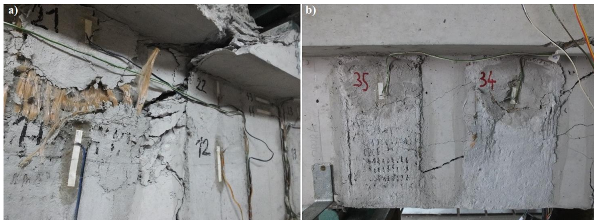
Rys. 4.34. Zniszczenie belek B_WS: a) zarysowanie zakotwienia i wyrwanie włókien PBO, b) zarysowanie zewnętrznej zaprawy świadczącej o poślizgu włókien na zaprawie
