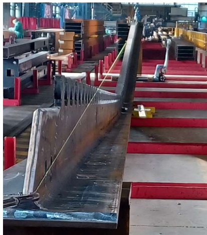
Rys. 42 Fragment konstrukcji stalowej – widoczna część dolna strefy podporowej
