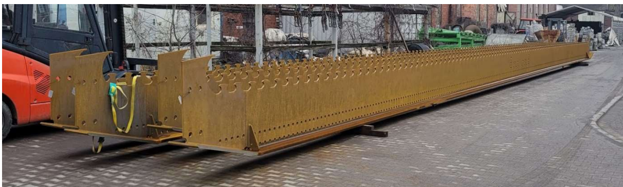
Rys. 43 Fragment konstrukcji stalowej – widoczna część górna strefy podporowej
