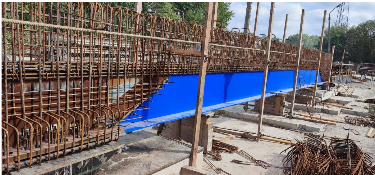
Rys. 25 Belka hybrydowa podczas prac zbrojarskich
