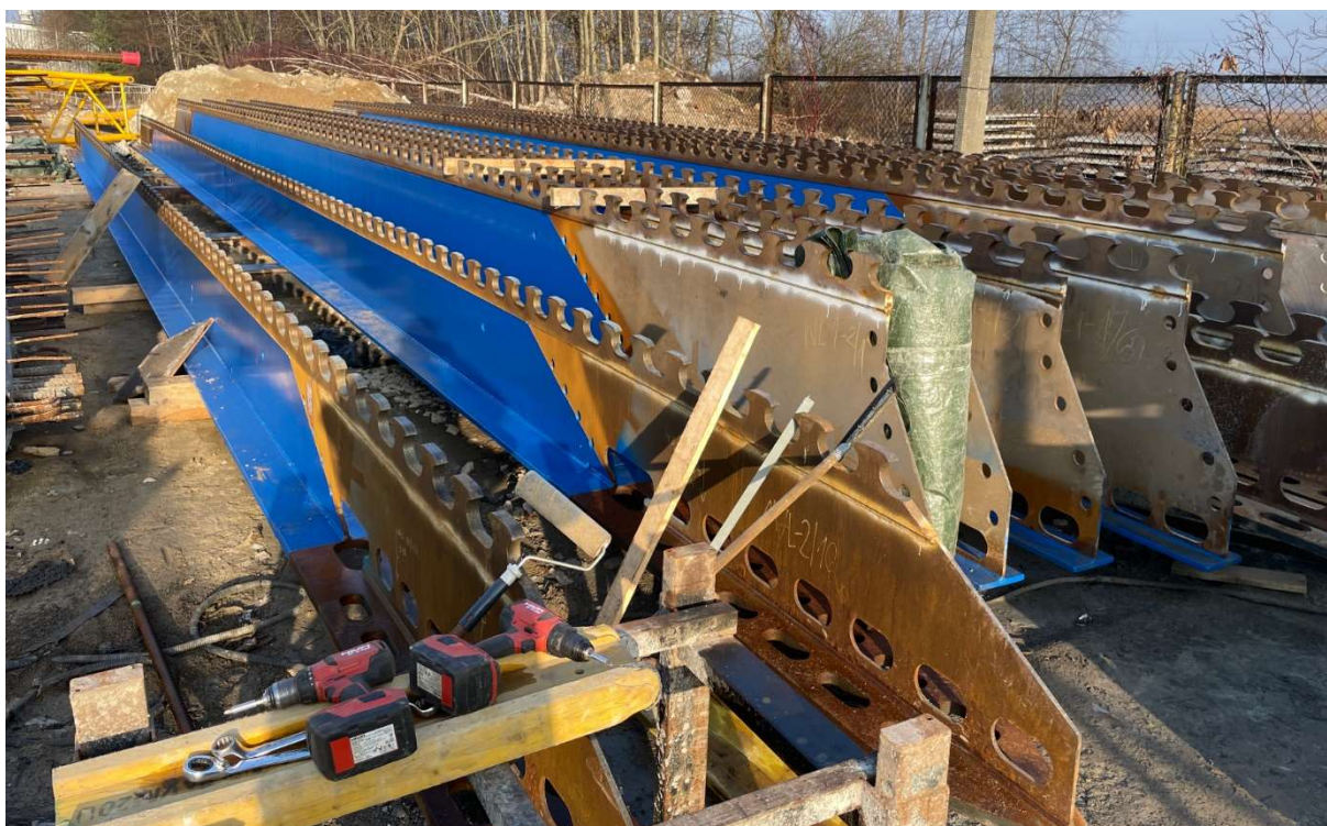
Rys. 24 Część stalowa belek hybrydowych
