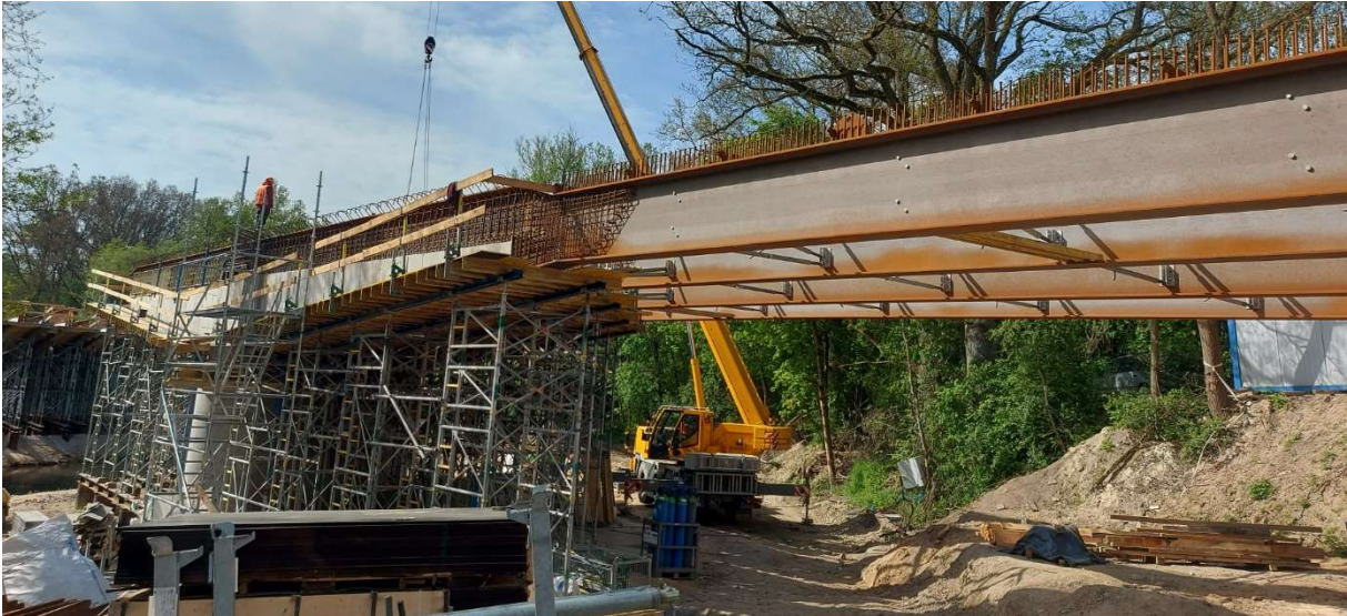
Rys. 44 Przesło skrajne i część strefy podporowej podczas realizacji obiektu
