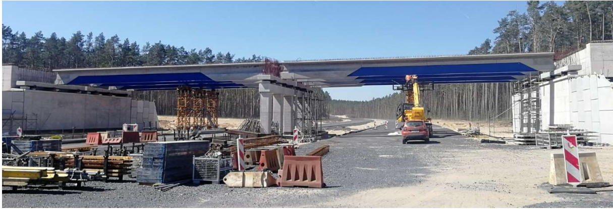
Rys. 27 Belki hybrydowe ułożone na podporach stałych i tymczasowych (w L/2 przęsła)
