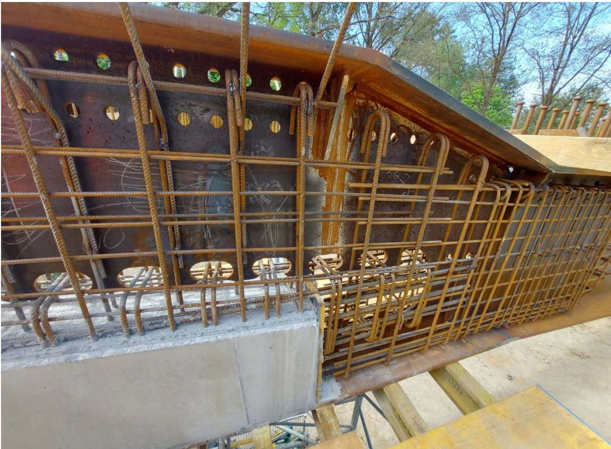
Rys. 45 Miejsce łączenia dźwigara walcowanego ze strefy przesłowej z częścią podporową (dźwigar „Krokodyl” zabetonowany do poziomu pod teownik górny)
