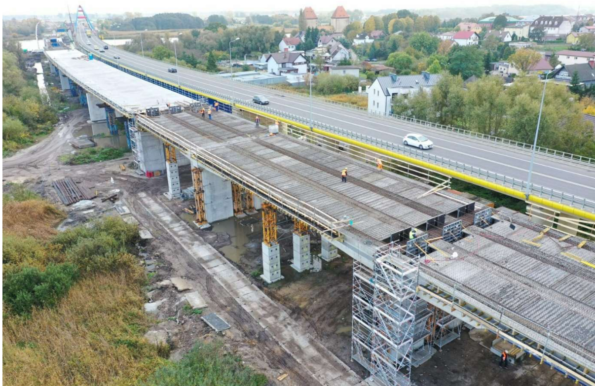
Rys. 29 Prace na moście M-7L (część dojazdowa 13 przęseł mostu w formie belki ciągłej uramowanej na 3 wewnętrznych filarach) ( s3.dargobadz-troszyn.pl/galeria )
