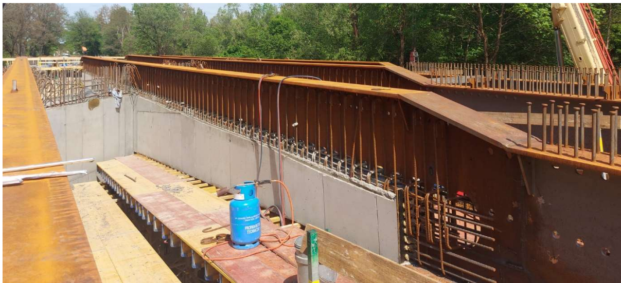
Rys. 46 Strefa podporowa mostu (dźwigar „Krokodyl” zabetonowany do poziomu pod teownik górny)
