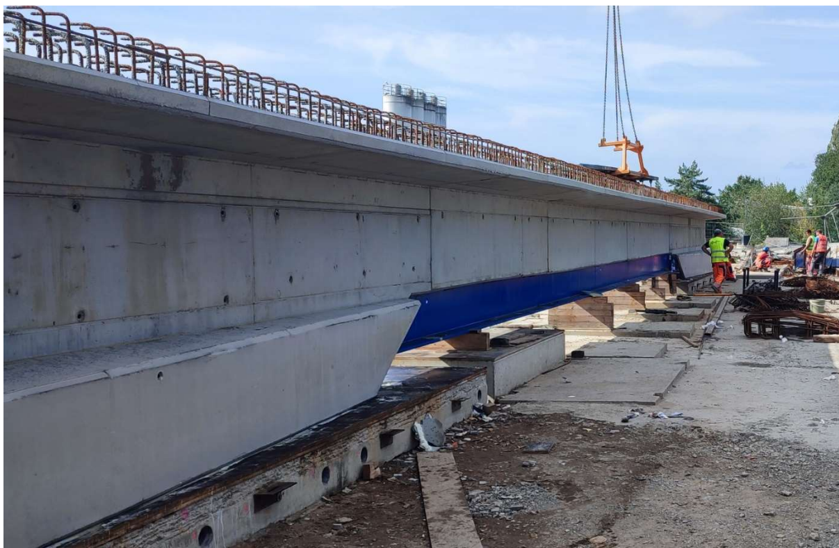
Rys. 26 Prefabrykowana belka hybrydowa
