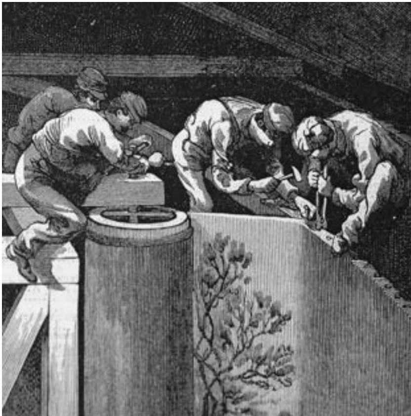
25. Rzemieślnicy w trakcie montażu obrazu panoramy na belkę nośną w budynku rotundy [za: „Scientific American” 1886]. Il. archiwalna
