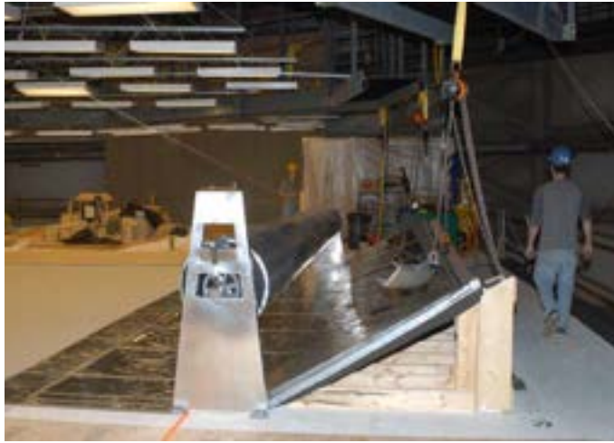
266. Foremnik startowy do zawieszania brytów i walec do przewijania brytów na platformie roboczej w nowym budynku rotundy cykloramy Bitwa pod Gettysburgiem , Gettysburg, 2007 rok. Fot. Ryszard Wójtowicz
