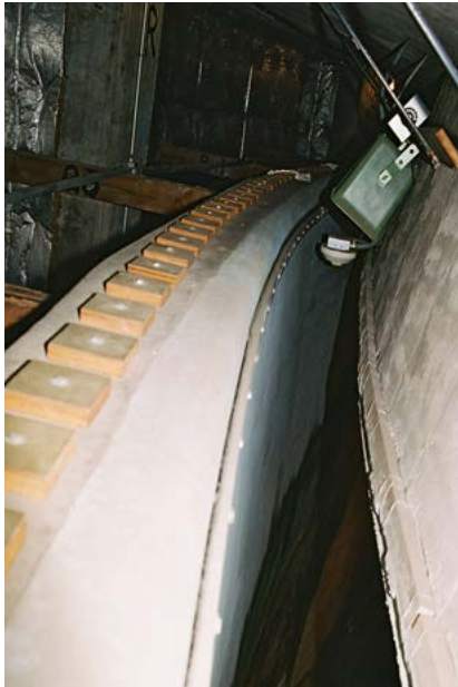
221. Cyklorama Bitwa pod Gettysburgiem w „starym” budynku, sposób zawieszenia obrazu wykonany w trakcie konserwacji Waltera J. Nitkiewicza, Gettysburg, 2006 rok. Fot. Ryszard Wójtowicz
