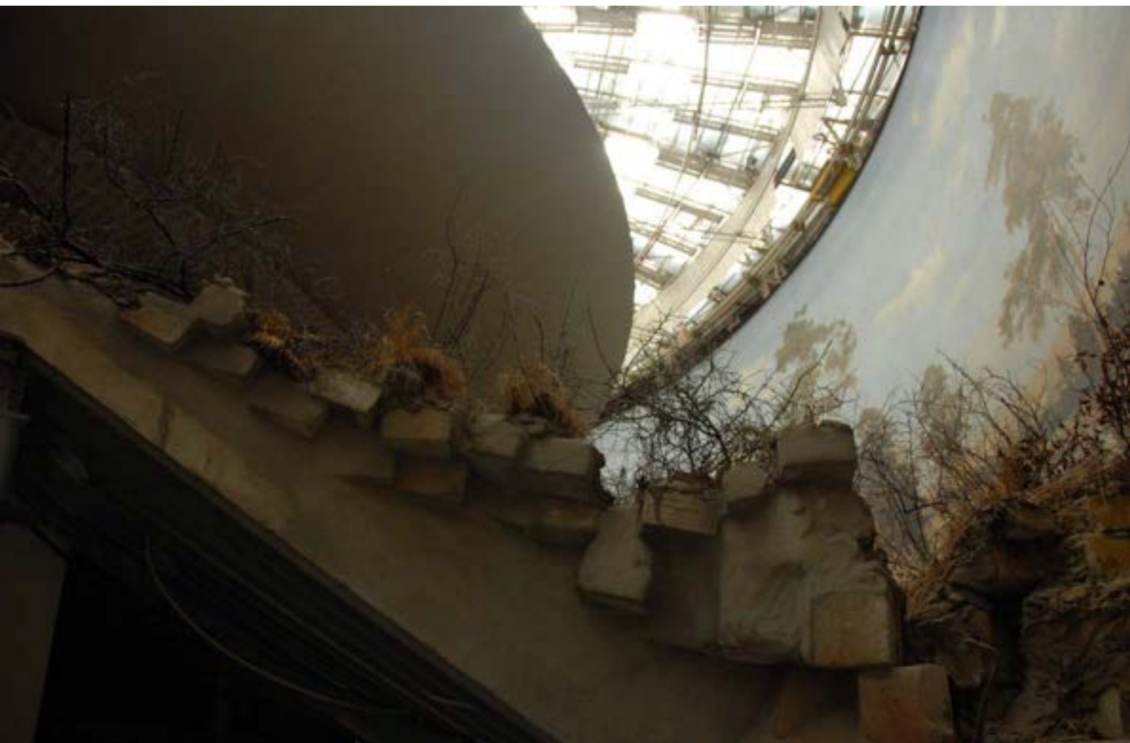
47. Wnętrze rotundy Panoramy Racławickiej we Wrocławiu z widokiem na elementy panoramy: obraz wraz z elementami zawieszenia, sztafaż, „parasol”, oświetlenie, 2014 rok. Fot. Ryszard Wójtowicz
