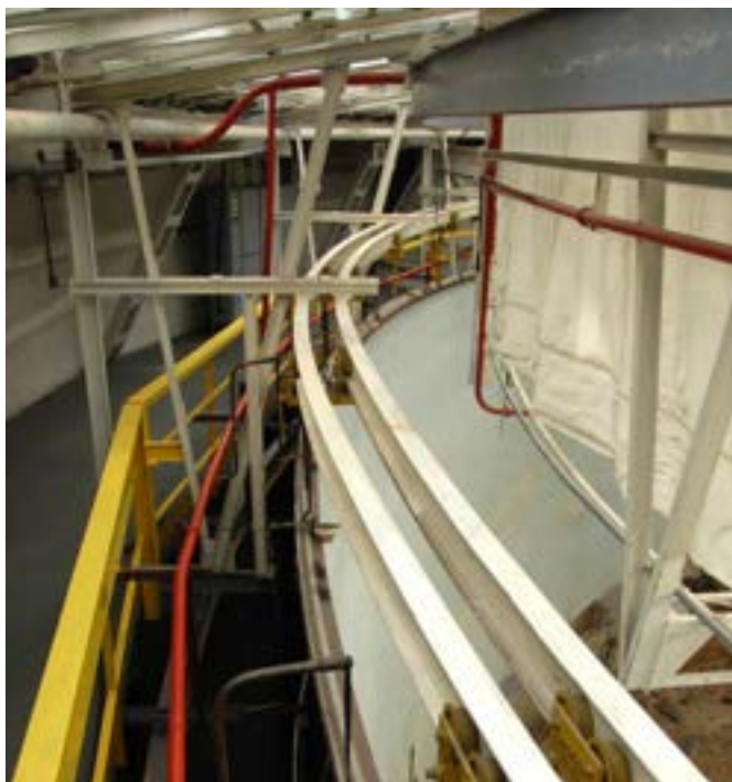
118. Górny system zawieszenia i korekty obrazu Panoramy Racławickiej we Wrocławiu, 2016 rok. Fot. Ryszard Wójtowicz
