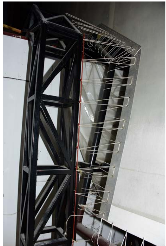
194. Elementy konstrukcji naprężającej fragmentu obrazu panoramy Wejście Węgrów , wejście do wnętrza sali ekspozycyjnej, Ópusztaśzer, 2016 rok. Fot. Ryszard Wójtowicz
