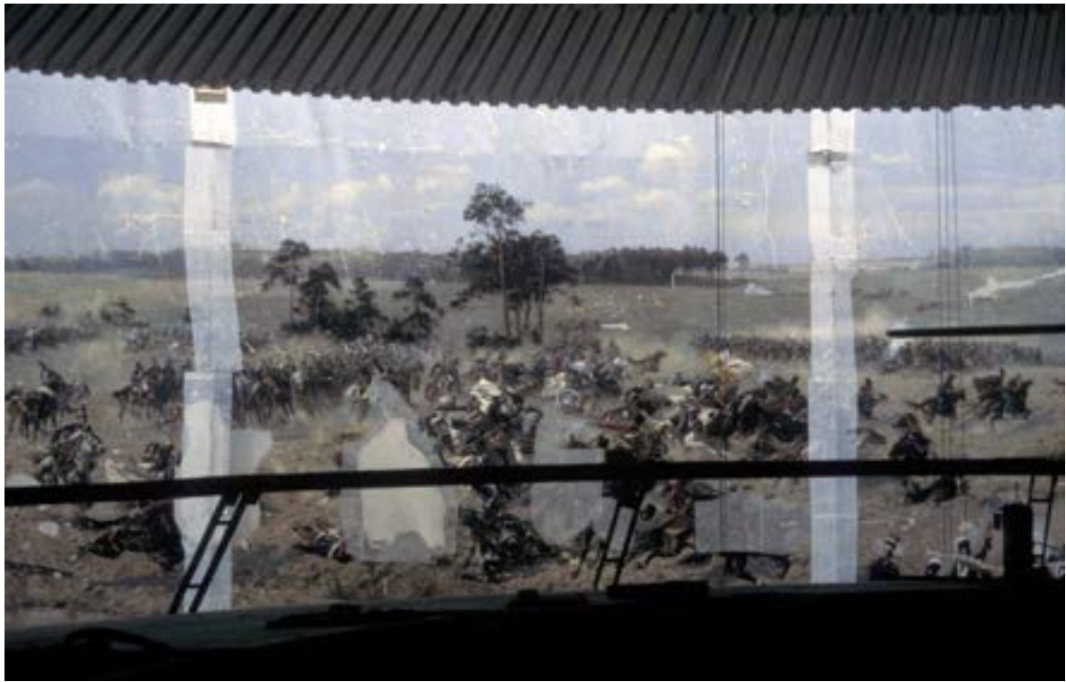
115. Jednoczesne ściągnięcie części (brytów) obrazu Panoramy Raławickiej w pozycji pionowej, 1983 rok. Fot. Ryszard Wójtowicz
