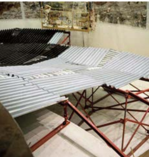
206. Fragment konstrukcji sztafażu panoramy Wejście Węgrów w trakcie krycia konstrukcji blachą stanowiącą podłoże dla warstw formujących, Ópusztaszer, 1994 rok. Fot. Jerzy Matuła
