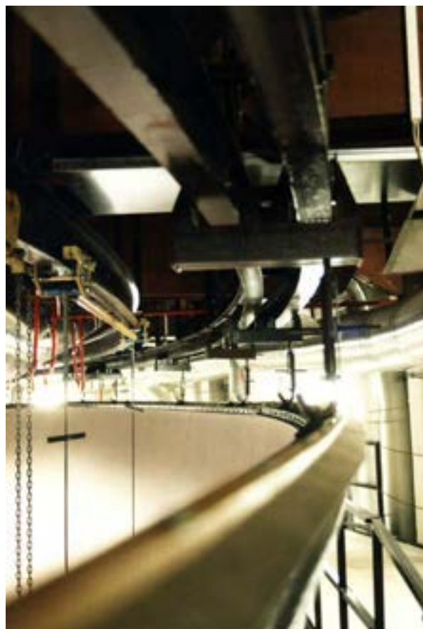
191. Elementy górnego systemu zawieszenia obrazu panoramy Wejście Węgrów , Ópusztaszer, 1995 rok. Fot. Ryszard Wójtowicz
