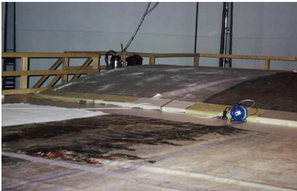
182. Bryty obrazu panoramy Wejście Węgrów na platformie roboczej w nowym budynku, przygotowane do prac przygotowawczych do zawieszania, Ópusztaszer, 1994 rok. Fot. Jerzy Matula
