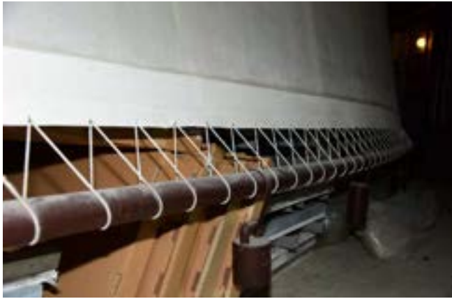
192. Elementy dolnego systemu naprężenia i obciążenia obrazu panoramy Wejście Węgrów , Ópusztaśzer, 2016 rok. Fot. Ryszard Wójtowicz
