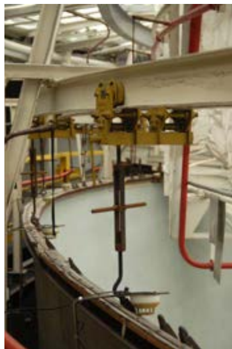
119. Elementy górnego system zawieszenia i korekty obrazu Panoramy Racławickiej we Wrocławiu, 2016 rok. Fot. Ryszard Wójtowicz
