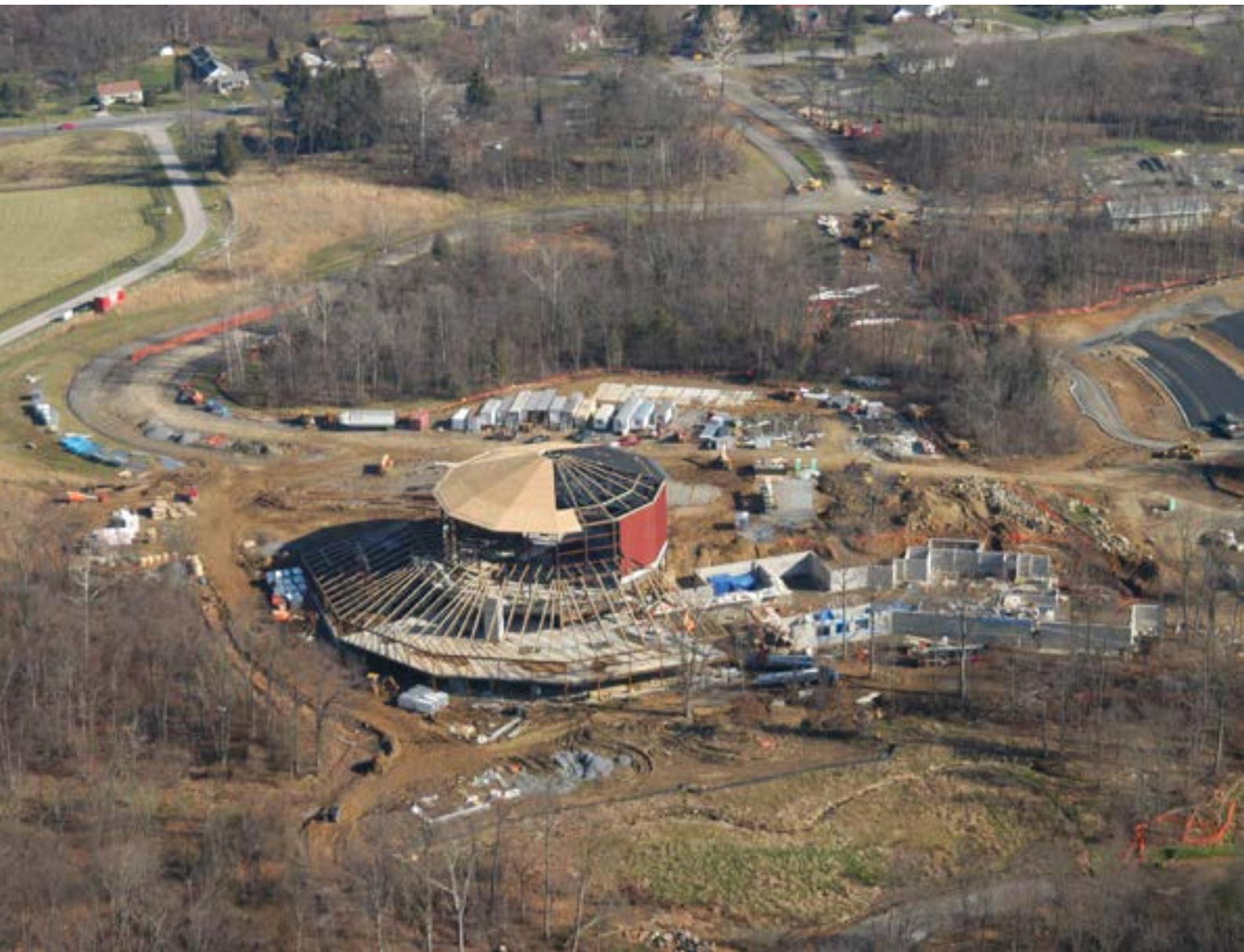
7. Centrum Historyczne w Gettysburgu w trakcie budowy. Fot. Gettysburg Foundation
