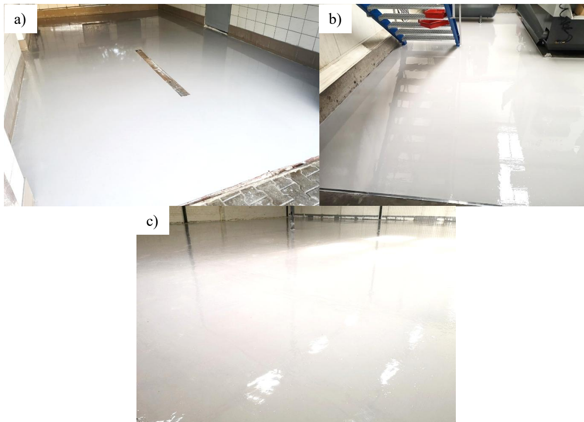
Rys. 102. Gotowe posadzki epoksydowe po pełnym utwardzeniu: a) wdrożenie 1 - warsztat samochodowy; b) wdrożenie 2 - fragment posadzki w hali produkcyjnej; c) wdrożenie 3 - warsztat samochodowy.
